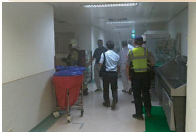
產房手術室上方天花板內冒出煙霧
