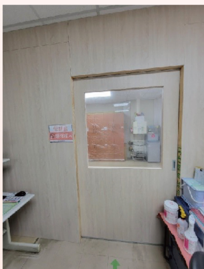
▲ 護理站圍籬工程，使用實體隔間、機動性與便利性極高的拉門，圍出綠色通道。
