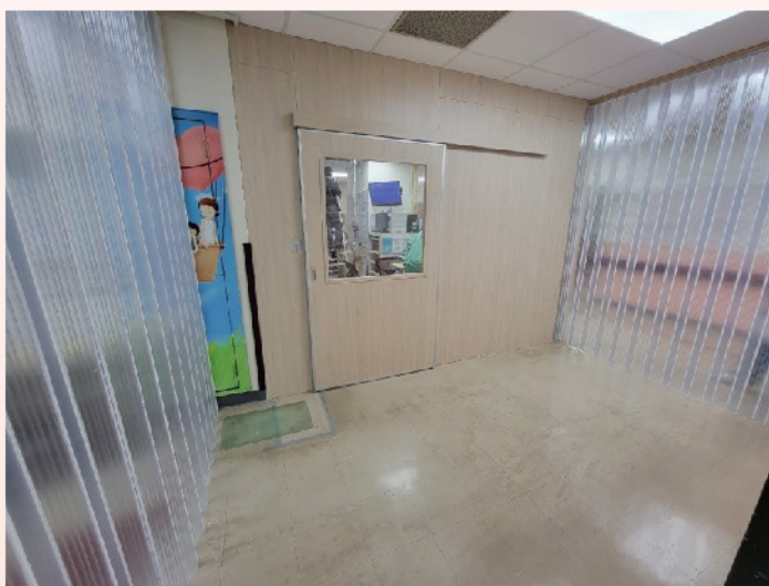
▲ 護理站圍籬工程，使用實體隔間、機動性與便利性極高的拉門，圍出綠色通道。
